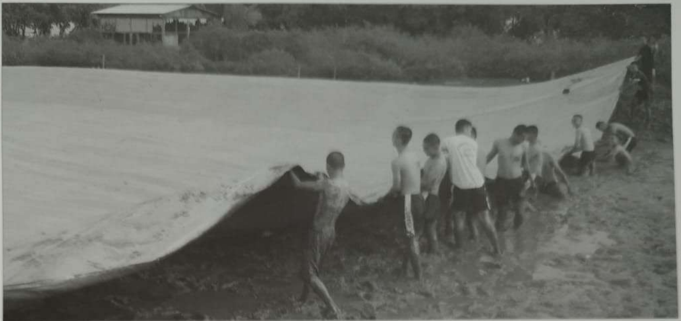
Pemasangan plastik pada lahan tambak tertutup. Operasional tambak tertutup dengan menggunakan plastik yang dipasang di atas lahan tambak untuk memudahkan pengelolaan air.
