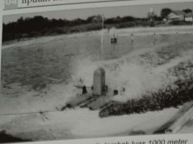
Operasional pemeliharaan pada tambak luas 1000 meter persegi yang ada di STP Serang.
