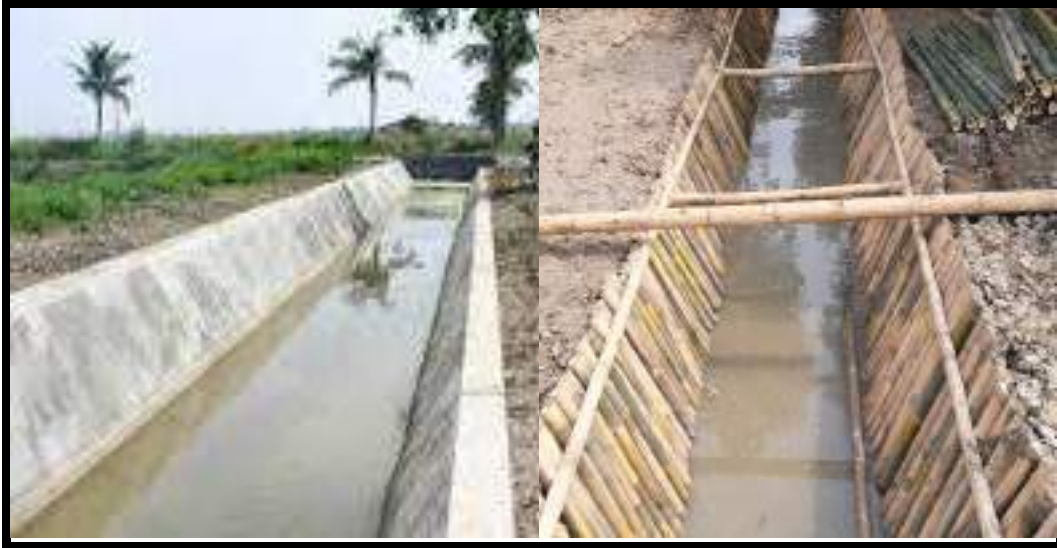
Gambar 21. Saluran air tambak dengan konstruksi beton (kiri) dan kayu/bambu (kanan)
