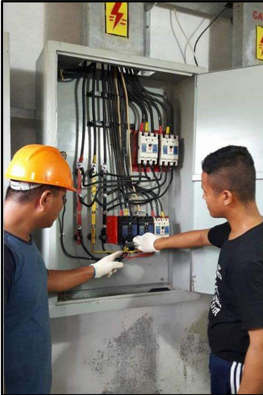
Gambar 27. Pembebanan Bertahap dengan menaikkan Tuas NFB
