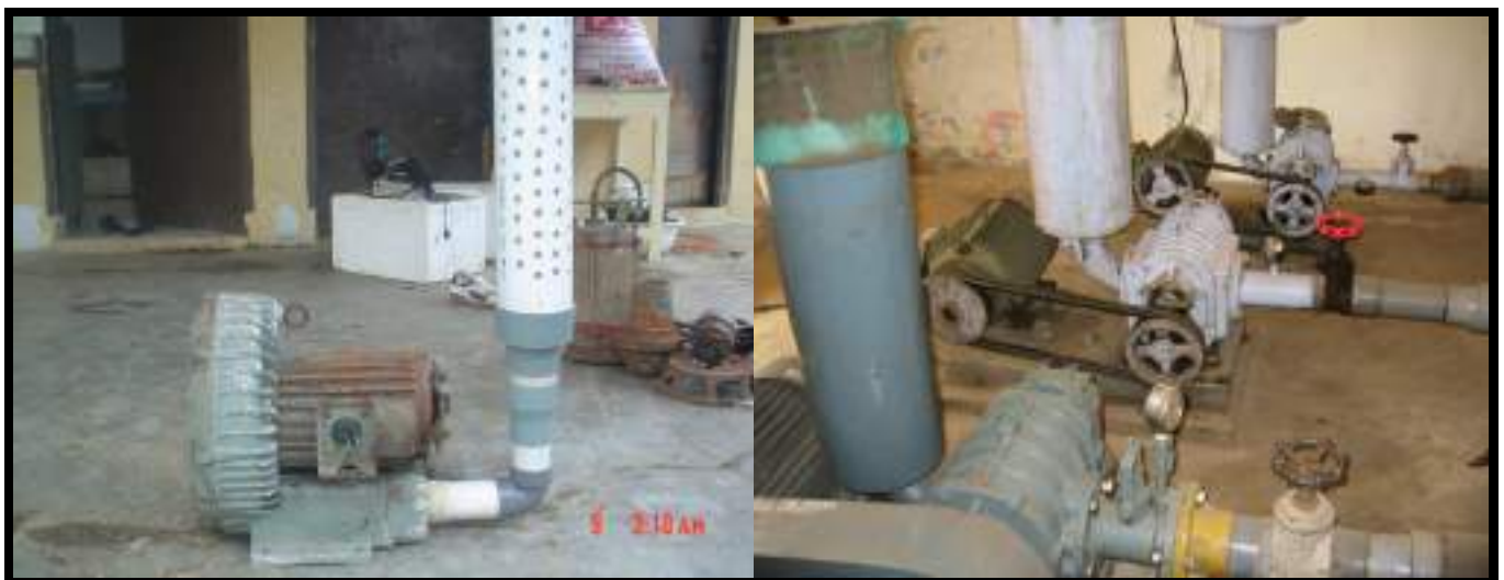
Gambar 12. Mesin Aerasi Blower. (kiri) Ring Blower dan (kanan) Root blower
