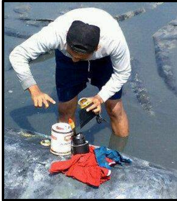
Gambar 11. Perbaikan wadah pada tambak plastik HDPE
