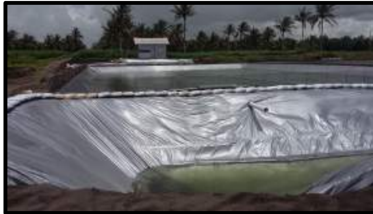
Gambar 28. Tambak dengan konstruksi plastik mulsa.
