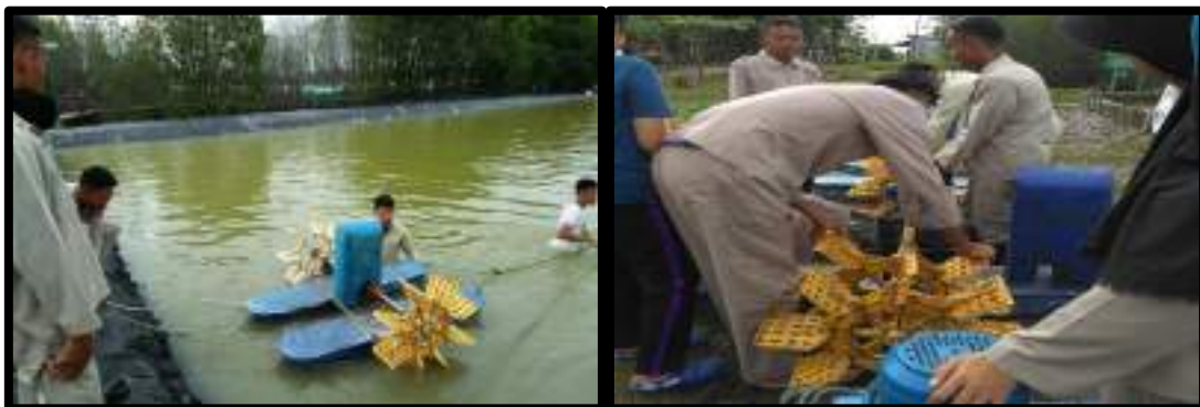
Gambar 33. Pemasangan kincir air
