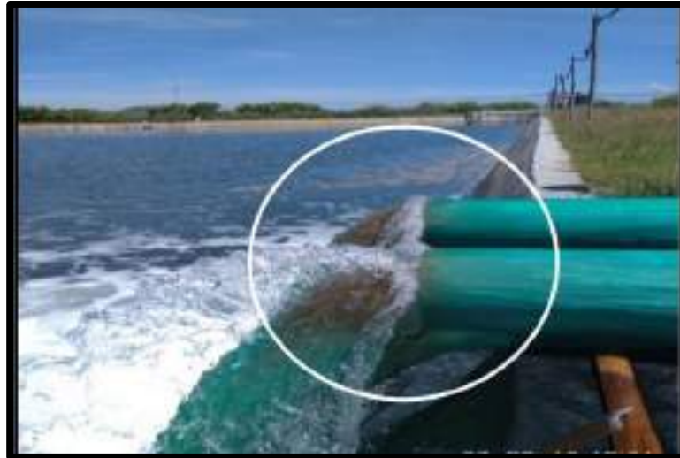
Gambar 32. Pengisian air dengan filter di pipa inlet (lingkaran putih).
