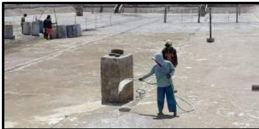
Gambar 31. Penyemrotan kolam beton dengan Chlorin
