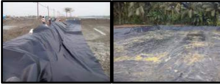
Gambar 26. Tambak dengan konstruksi HDPE.
