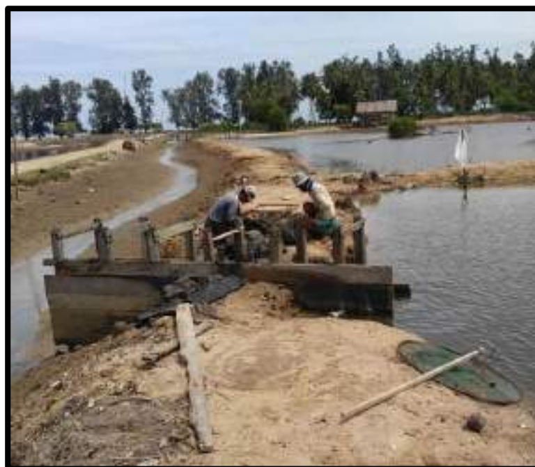
Gambar 9. Perbaikan pintu air kayu pada tambak tradisional
