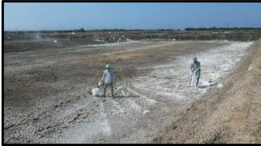
Gambar 17. Pengapuran tanah dasar tambak.
