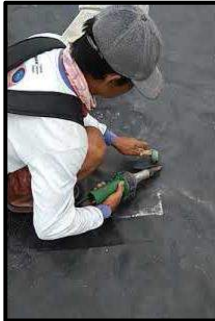
Gambar 11. Penambalan plastik HDPE menggunakan Leister
