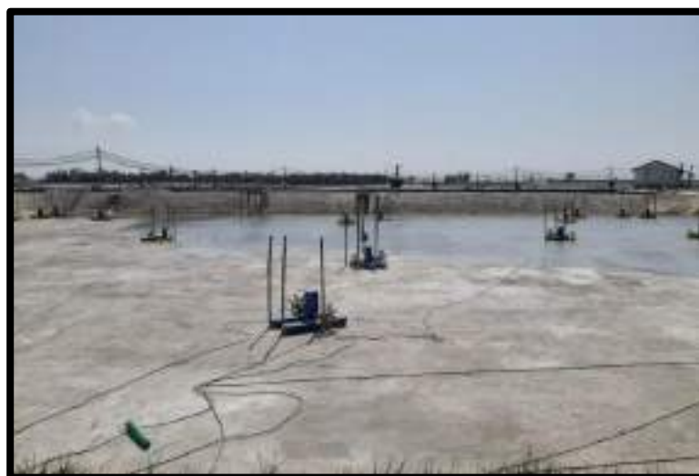
Gambar 29. Persiapan pada tambak beton.
