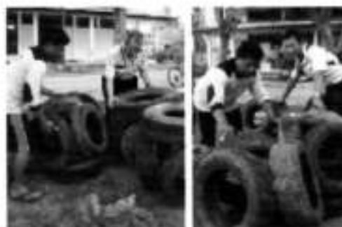
Gambar 5. Terumbu karang buatan yang terbuat dari ban sebelum dipasang di pulau Lima Teluk Banten.
